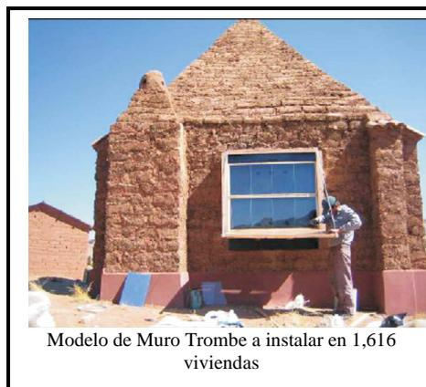
Modelo de Muro Trombe a instalar en 1,616 viviendas
